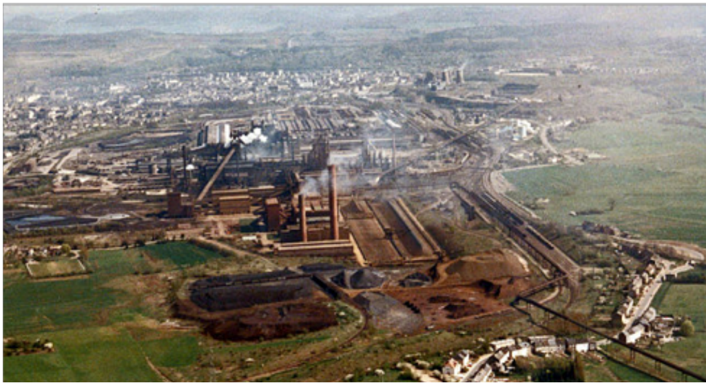
Figure 31 – Belval-Ouest : de la sidérurgie à la ville « lien »
